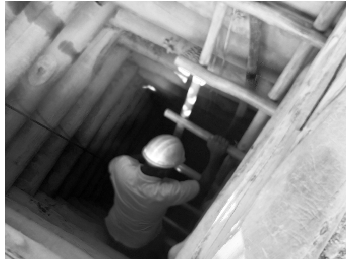
Figura 15: Poço de mineração com paredes seguras
